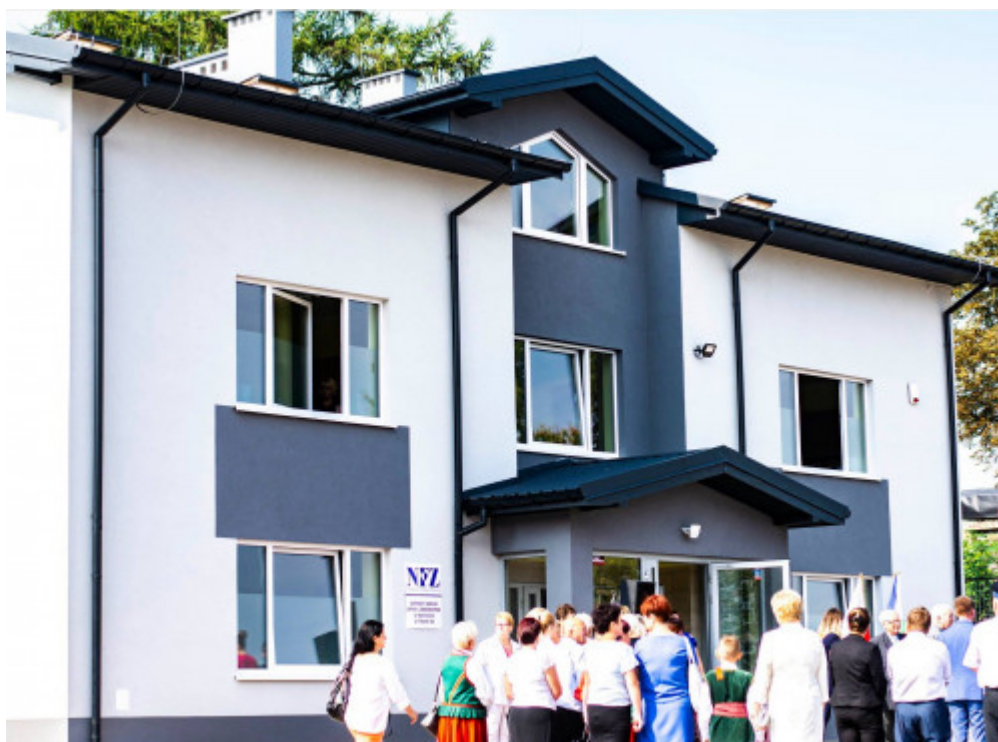
Budynek ośrodka zdrowia w Waśniowie
