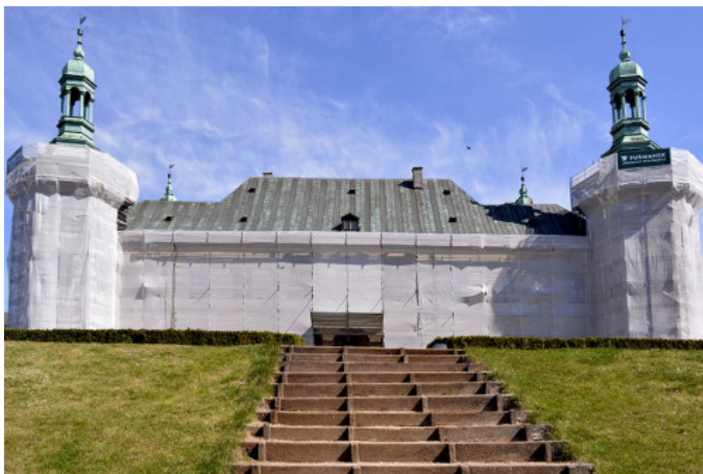
Trwa remont elewacji Pałacu Biskupów od strony ogrodów
