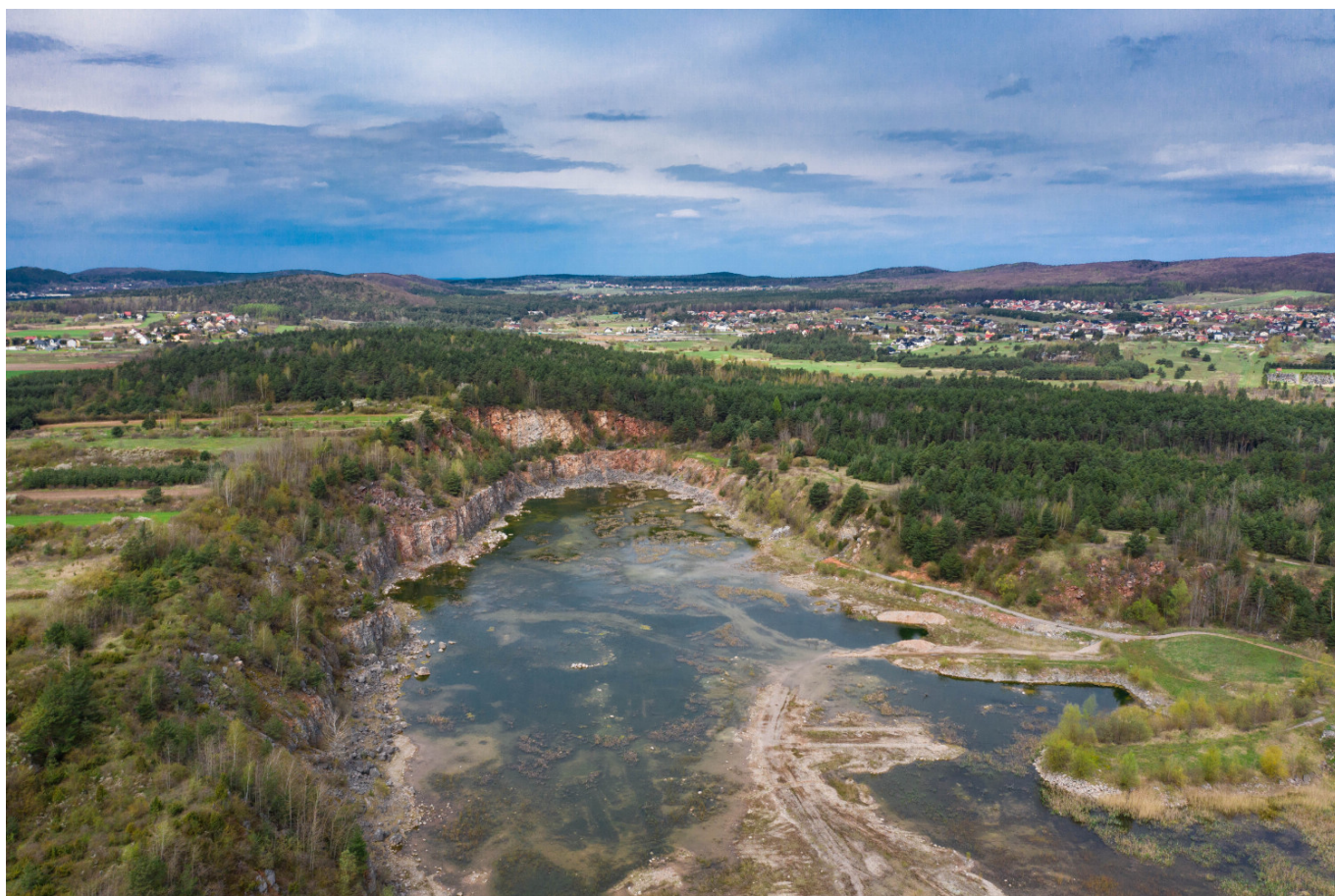
Kamieniołom w Nowinach
