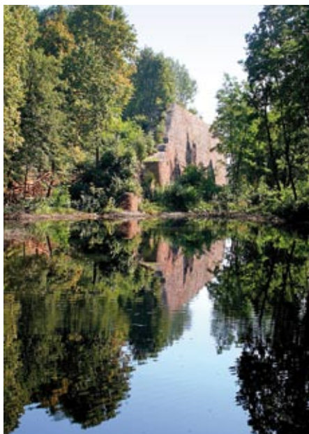
Mur oporowy i staw w Zabytku Techniki - Zakład Wielkopiecowy w Bobrzy
