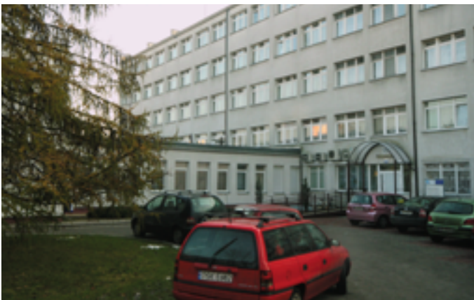
Po remoncie w budynku WSZON powstanie Świętokrzyskie Centrum Neurologii
